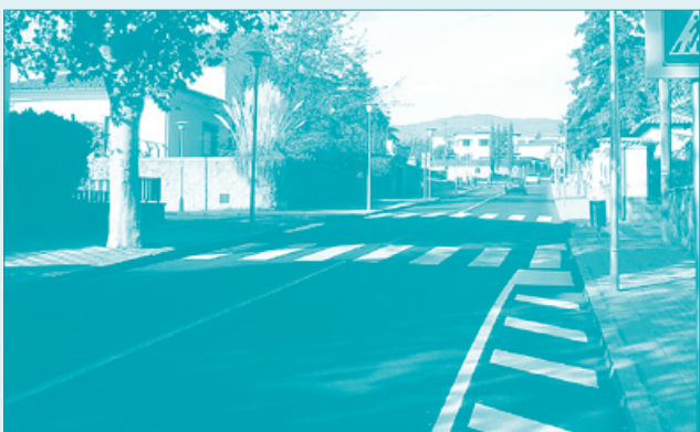
Reasfalt de la ctra. manresa, una obra molt necessària
