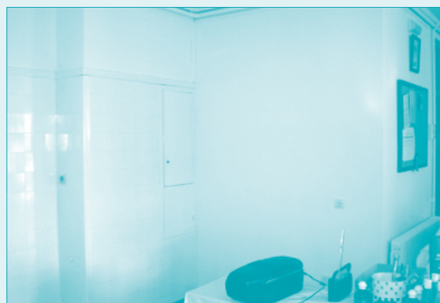
Pintura despatx assistencial.
