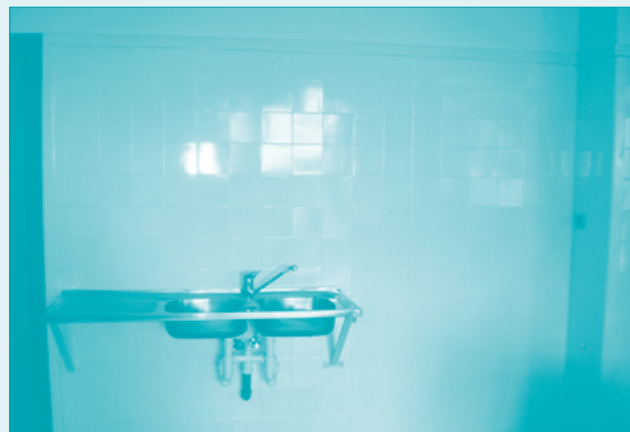
Instal·lació de rentamans al despatx assistencial.
