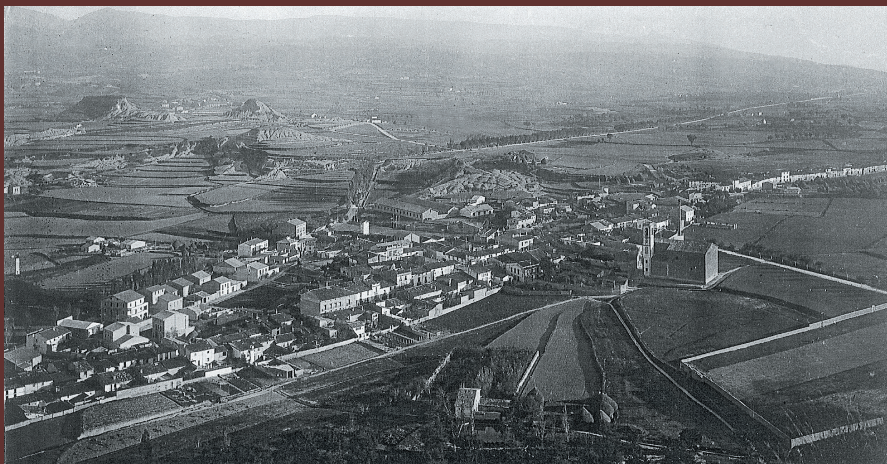
Tona, en 1928. A la dreta, la iglesia parroquial de Sant Andreu antes de su destrucción a principios de la Guerra Civil y, un poco más allá, la hilera de casas del Carrer Nou [L. Roisin / Arxiu Municipal de Tona. Col·lecció L'Abans. Fons Arxiu Ramon Batllés]
