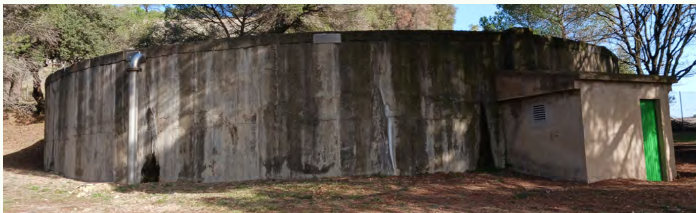
Imatge del dipòsit del Vilar abans de les obres de millora
