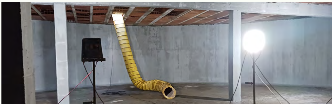
Imatge de l'execució de les obres de millora
